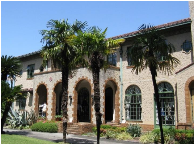
『ベーリック・ホール』
